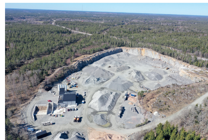
Vy över Rödsle bergtäkt och betongstationen.
