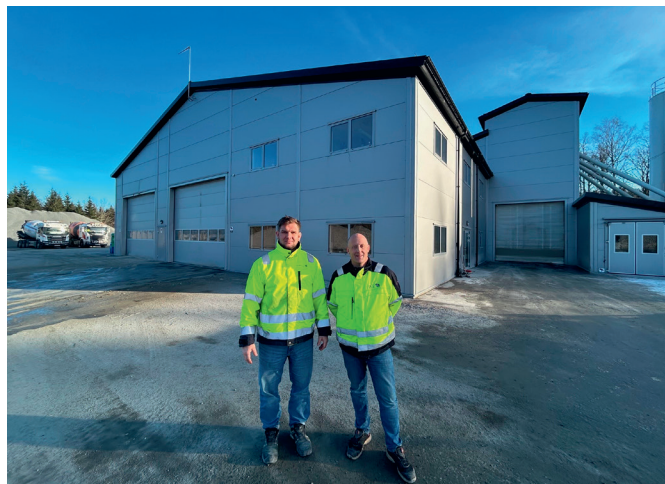
Krzysztof och Robert framför den nybyggda betongstationen söder om Västervik.
